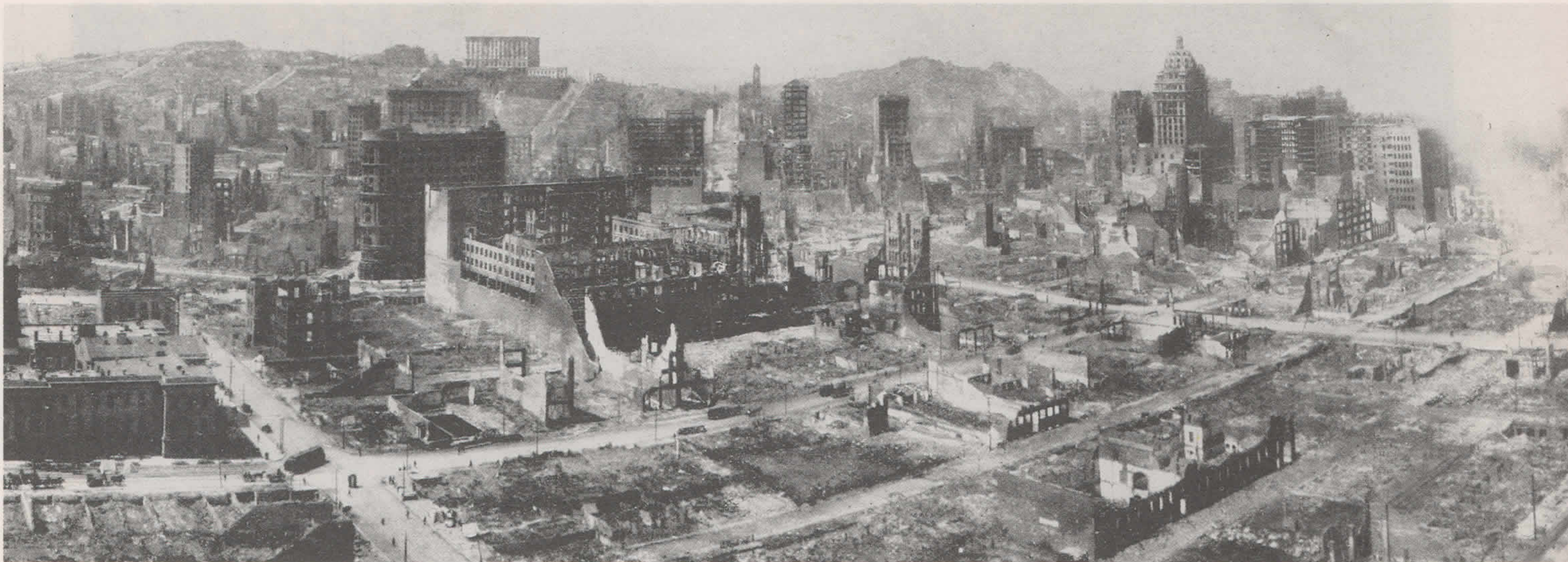
A devastação causada pelo tremendo terremoto de San Francisco em 18 de abril de 1906. O terremoto e os incêndios que provocou arrasaram dez quilômetros quadrados da cidade, matando setecentas pessoas. O terremoto foi causado por um movimento súbito ao longo da falha de San Andreas (à esquerda), indicando uma região da superfície da Terra em que “placas” adjacentes da crosta estão em atrito. Um desastre semelhante pode ocorrer novamente a qualquer momento.
